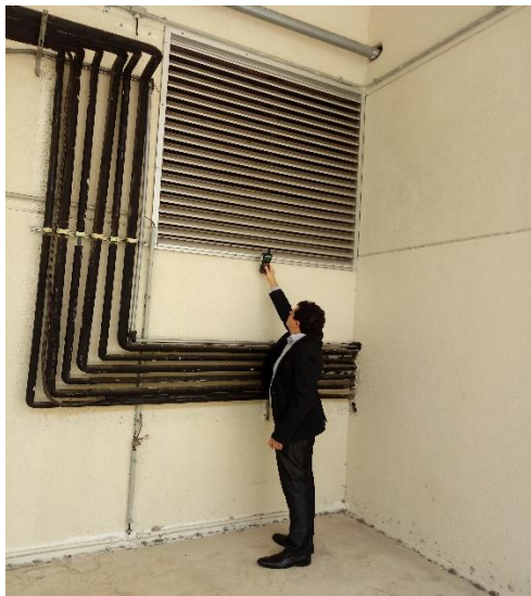
Foto 1 Medição face externa da T.A.E
